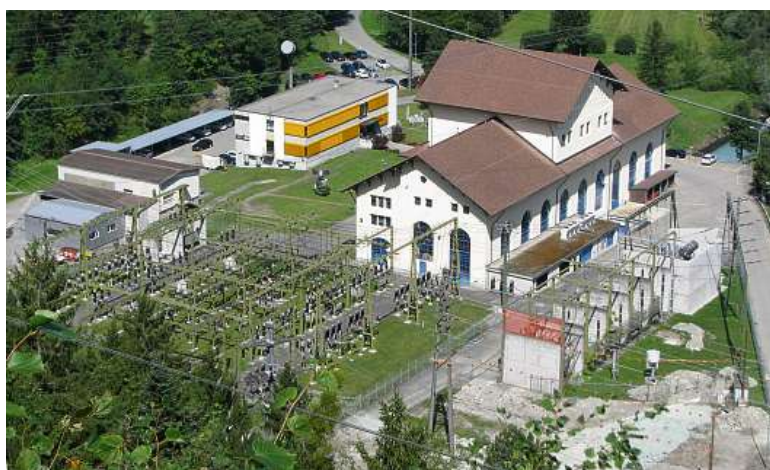
Die Erneuerung des Kuppelunterwerks Sils Albula soll langfristig die Stromversorgung in Graubünden sichern. (ZVG)
