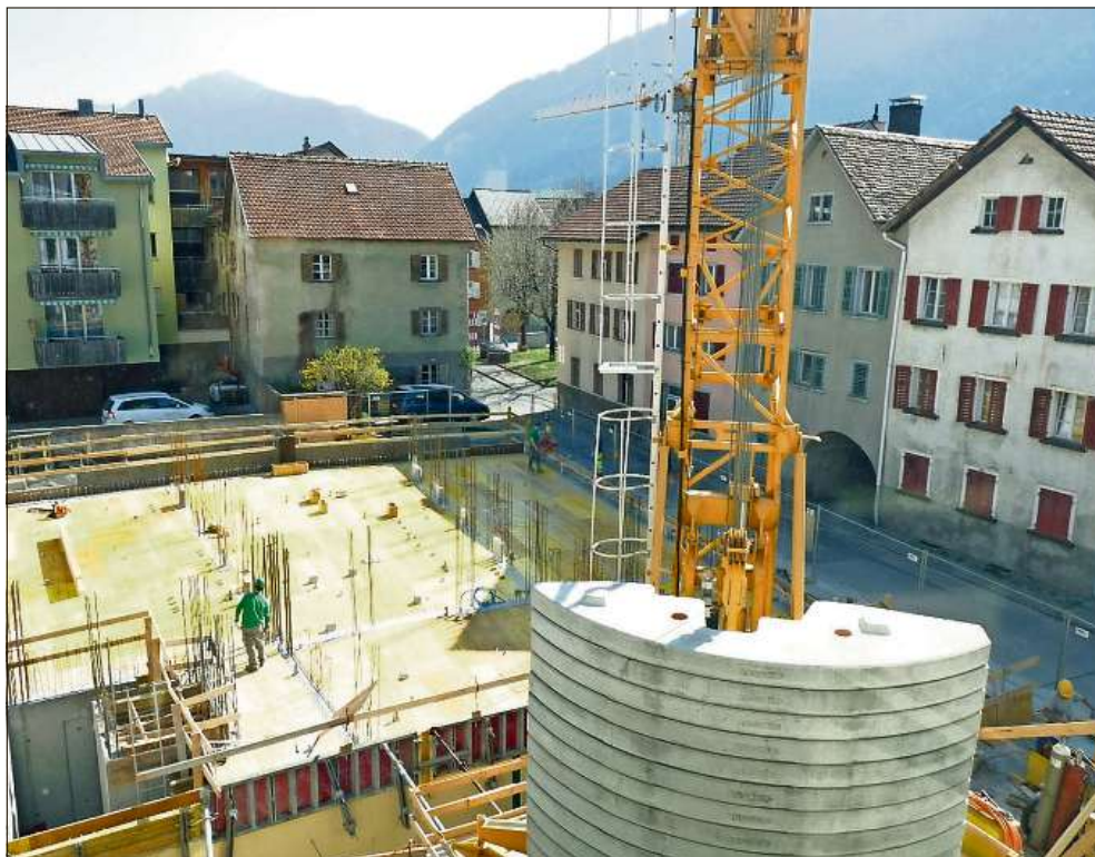
Mit dem Einzug in das Verwaltungsgebäude, das gegenwärtig im Bau ist, in einem Jahr, unterstreicht Domat/Ems die Position als Verwaltungszentrum der Region. Bild zvg
